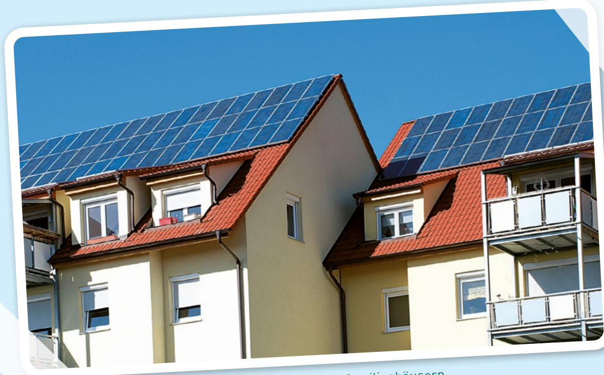
Solarzellen auf den Dächern von Mehrfamilienhäusern
